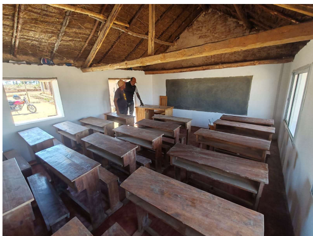
Enduits et peinture des salles
