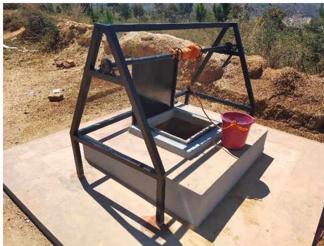
Tête de puits et treuil de relevage
