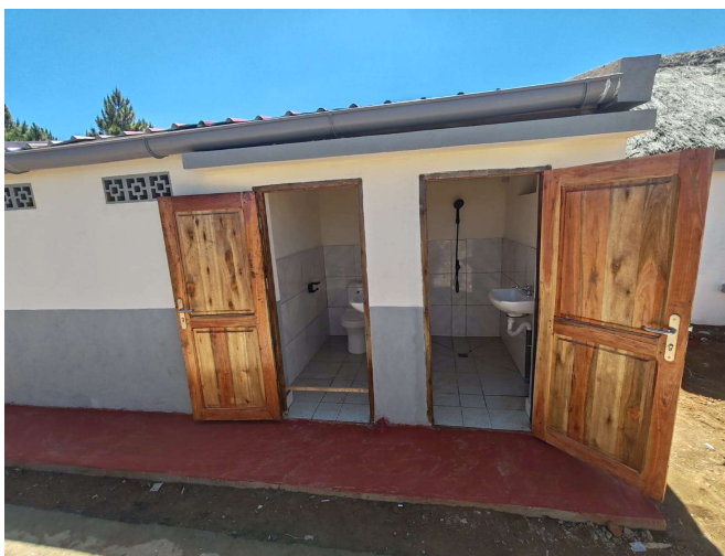
Douche et toilettes
