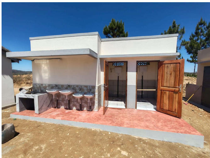
Nouveau bloc sanitaire
