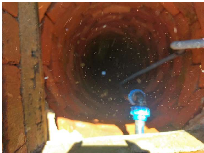
Puits de 15m et pompe solaire
