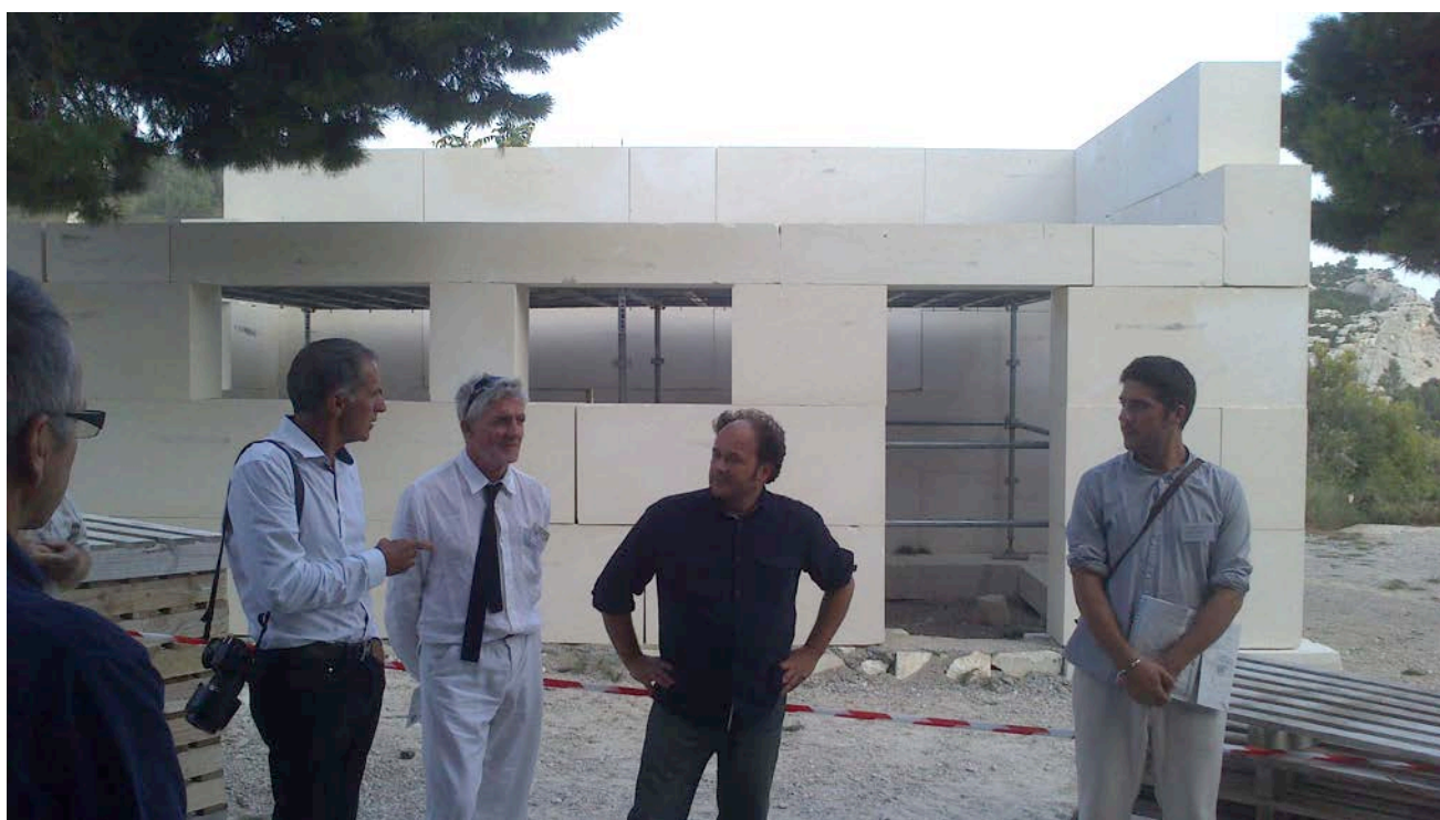
Paul Mariotta (Pierres du Sud), Philippe Poggi (Proviseur du lycée Les Alpilles), Jérôme Solari (SARL Solari et assoc.) et Simon Darves-Blanc (DBS Pierre), devant la construction en pierre massive posée par l'équipe du lycée professionnel Les Alpilles de Miramas durant la journée de vendredi. Photo : Charlotte Nguyen
