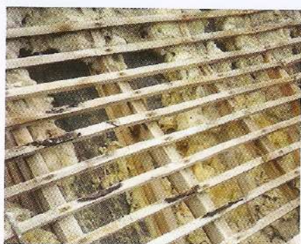
Isolant sous toiture installée sans lame d'air ventilée en sous-couverture. La condensation a détrempe la laine de verre qui s'est alourdie et affaissée. Doc. BatiEthic.
