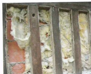
Ce qu'il reste de rouleaux isolants entre une contre-cloison en briques et un mur en pans de bois. Le torchis d'origine entre les pans de bois n'a pu évacuer l'humidité, étant lui-même revêtu d'un enduit ciment. C'est le pourrissement du pied des pièces en chêne (et les consommations thermiques !) qui ont donné l'alerte. Doc. BatiEthic.
