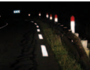
L'utilisation de dispositifs réfléchissants les phares des voitures permet, dans certains cas, de remplacer avantageusement un éclairage public.
