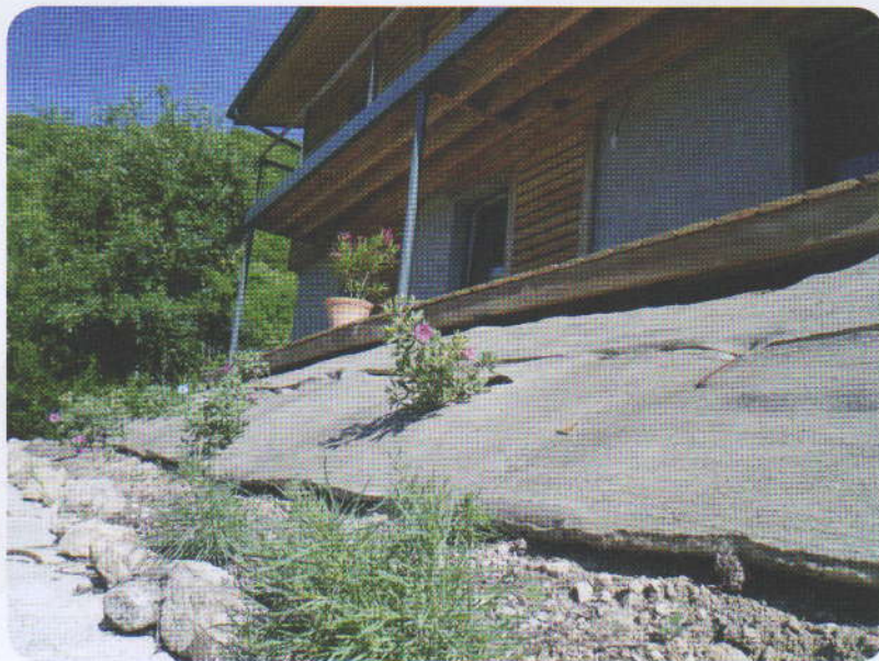
Feutre agricole en situation sur un talus. 1000 g/m 2 , placé en juin 2014. Merci à Laurence et Bernard, clients solidaires, pour le test et la photo!
